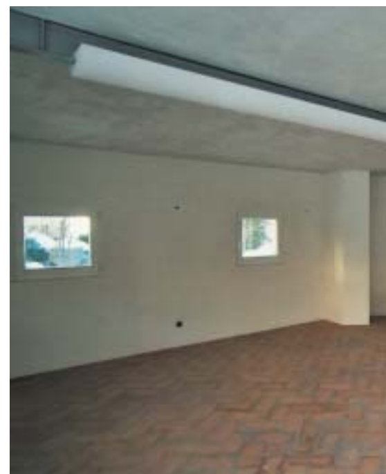
Der Abstellraum im Rohbau mit noch unbunten Wänden
